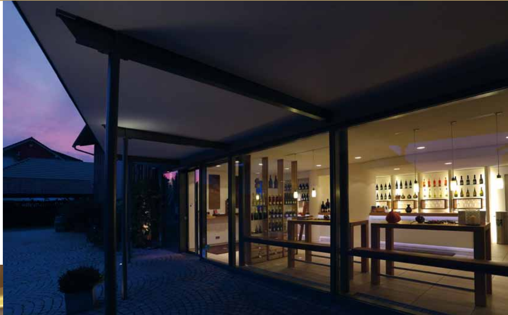
▲ Vor die neue Vinothek wurde eine Pergola auf filigrane Stahlstützen gestellt
